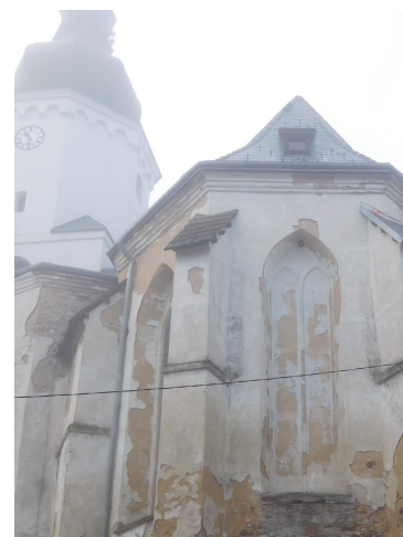
Oprava fasády kněžiště
