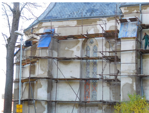
Dokončení fasády severní strany č.2
