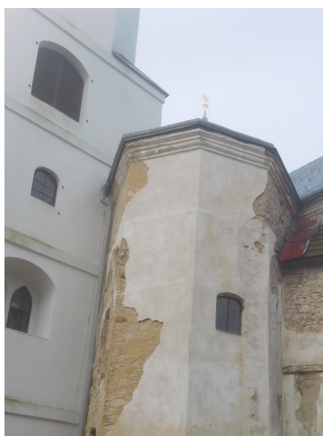
Oprava fasády schodiště na oratoř
