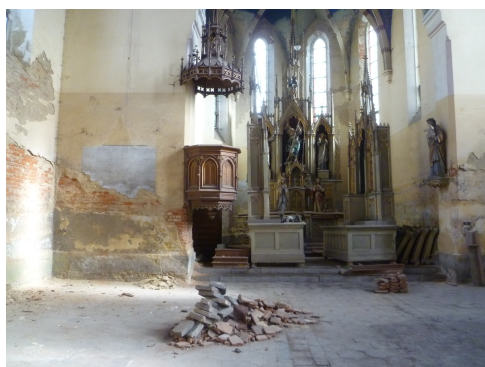
Stav před opravou interiéru pohled k hl.oltáři
